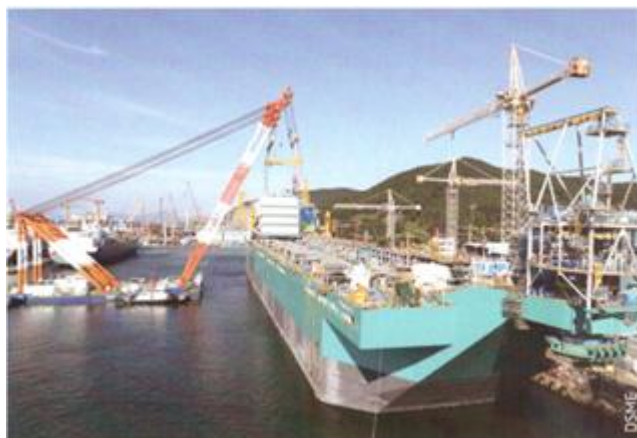
Рис. 4.4. Установка первого из 21 верхних модулей плавучего комплекса СПГ FLING 1 компании Petronas
