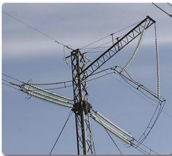
Рисунок 2.4 – Расщепленная фаза провода
