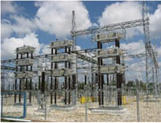
Рис. 7.6 Общий вид монтажа конденсаторной батареи 220 кВ
