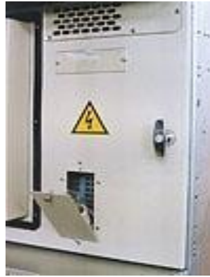
Рисунок 2.8.5 - Смотровые окна. Визуальное наблюдение видимого разрыва контактов разъединителя.
