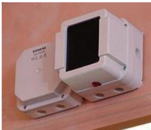
Рисунок 2 – Линейный извещатель
