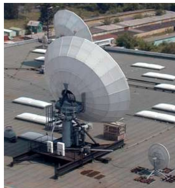
Рис. 5.9. Пример несущей конструкции антенны
