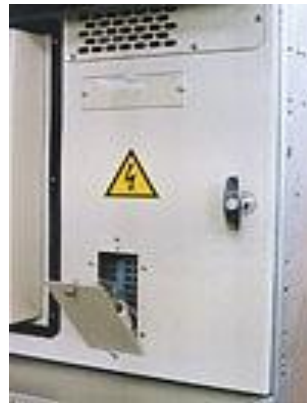
Рисунок 2.8.5 - Смотровые окна. Визуальное наблюдение видимого разрыва контактов разъединителя.
