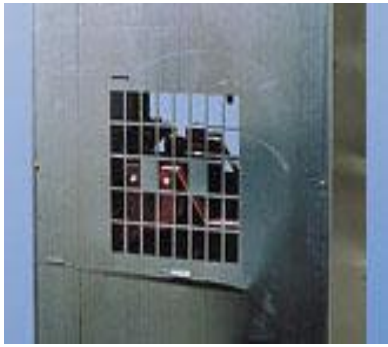
Рисунок 2.8.4 - Разгрузочные клапаны, На задней стенке ячейки имеются разгрузочные клапаны, предназначенные для предотвращения раздувания ячейки и сброса давления в коридор обслуживания.
