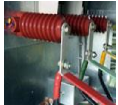
Рисунок 2.8.13 - Емкостные делители, встроенные в опорные изоляторы, предназначены для преобразования высокого напряжения в сигнал низкого напряжения для использования в блоках индикации.
