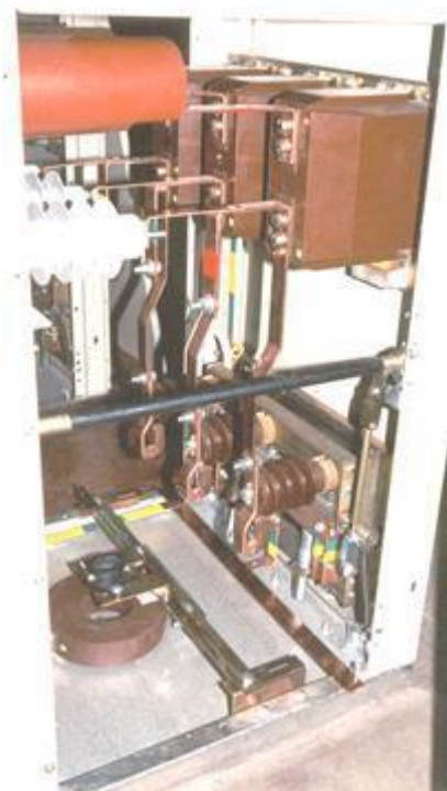
Рис. 7.5. Кабельный отсек
