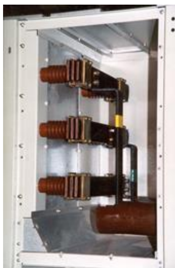
Рис. 7.3. Отсек сборных магистральных шин
