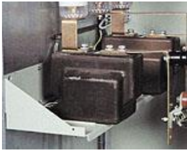
Рисунок 2.8.11 - Трансформаторы тока ТОЛ, предназначены для преобразования тока высокого напряжения в сигнал измерительной информации для использования в измерительных приборах и устройствах защиты и управления.
