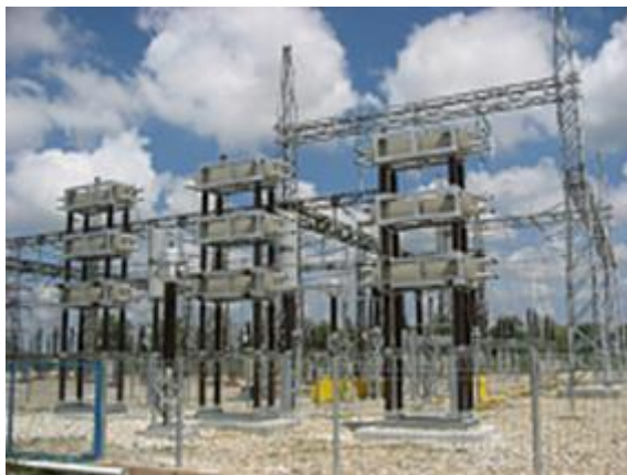
Рис. 7.6 Общий вид монтажа конденсаторной батареи 220 кВ
