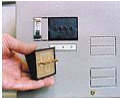
Рисунок 1.8.12 - Блоки индикации напряжения на шинах или на кабеле и гнезда для фазировки на низком напряжении и постоянный визуальный контроль наличия напряжения.
