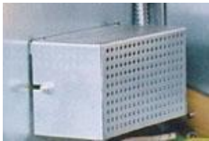
Рисунок 2.8.14 - Антиконденсатные нагревательные элементы, Для поддержания нормальных условий работы оборудования по температуре и влажности в ячейках устанавливаются нагревательные элементы, работающие в автоматическом режиме.
