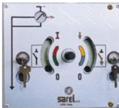
Рисунок 2.8.2 - Механический указатель положения подвижных контактов. Жестко связан с валом разъединителя
