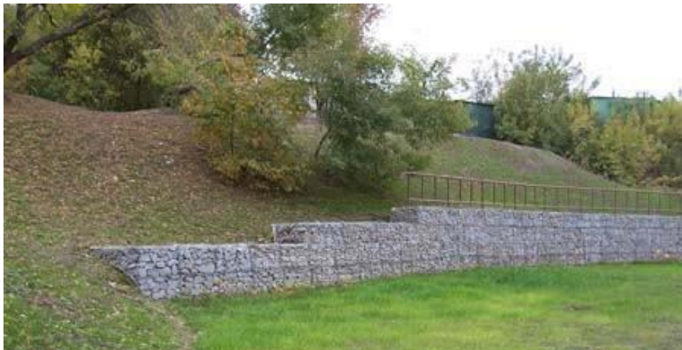
Рис. 18. Подпорная стенка из габионных блоков
