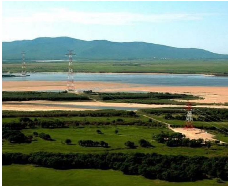
Рисунок 9.2 – Переход воздушной линии 500 кВ через реку Амур.
