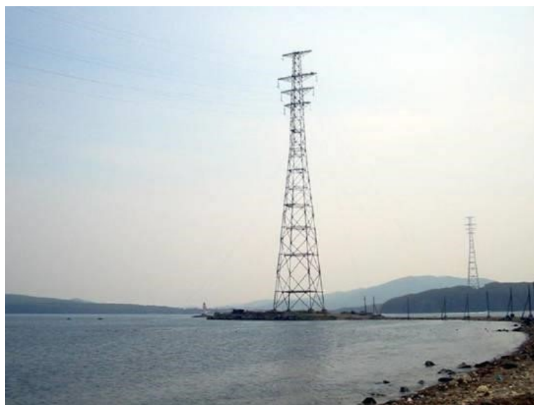
Рисунок 9.1 – Переход воздушной линии 35 кВ через пролив Босфор-
