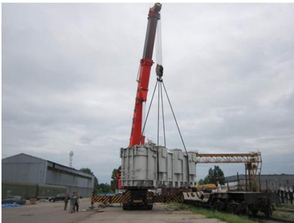
Рисунок 4 – Разгрузка силового трансформатора краном
