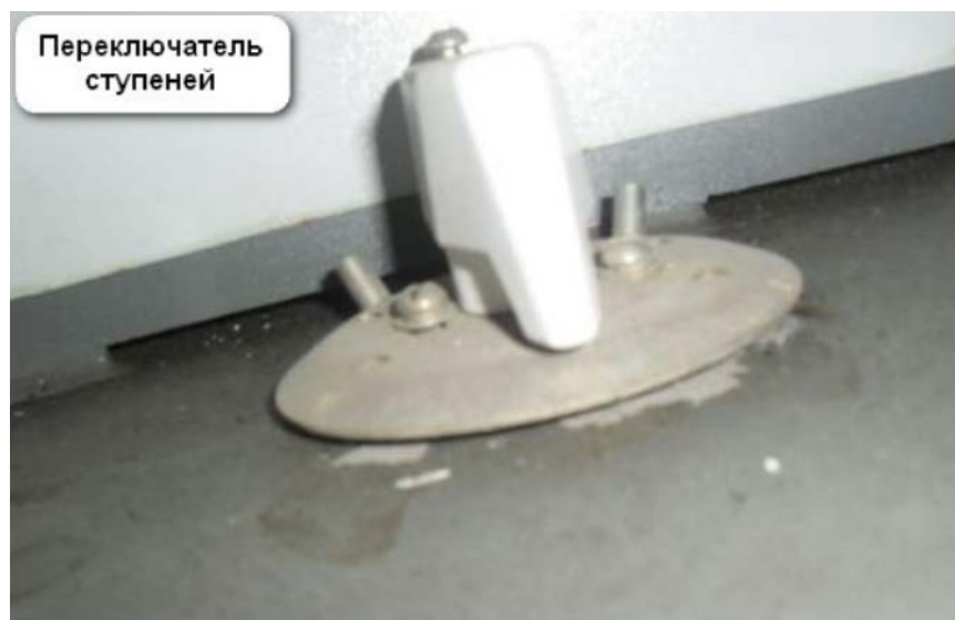
Рисунок 30 – Переключатель ступеней переключения
