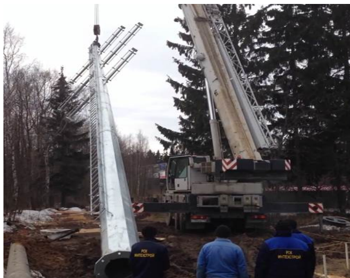
Рисунок 8 – установка опоры с помощью крана
