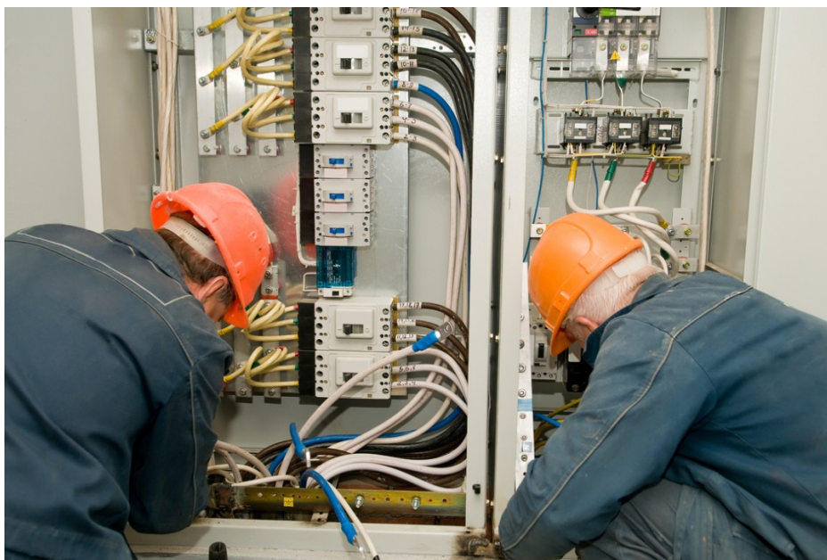
Рисунок 8 – Ремонтные работы в КРУ
