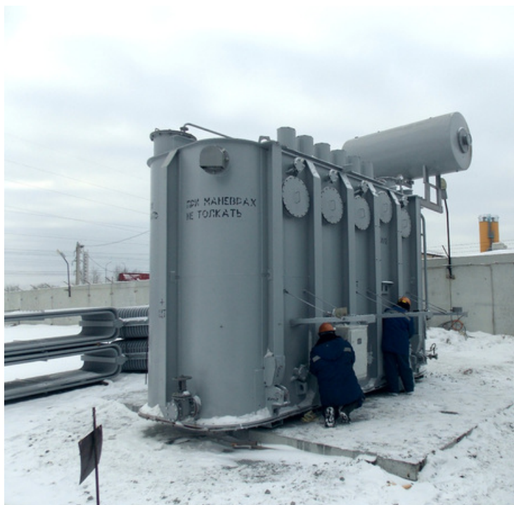
Рисунок 11 – Монтажные работы в зимнее время
