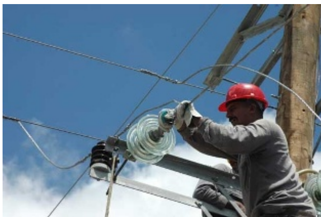
Рисунок 12 – Регулировка стрел провеса проводов.
