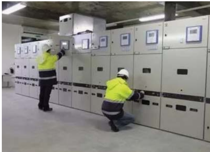
Рисунок 1 – Монтаж КРУ
