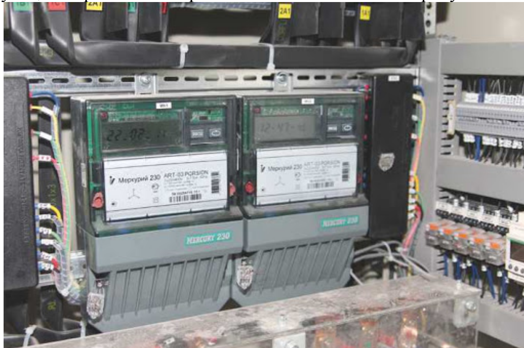
Рисунок 14 – Наладка системы АСКУЭ
