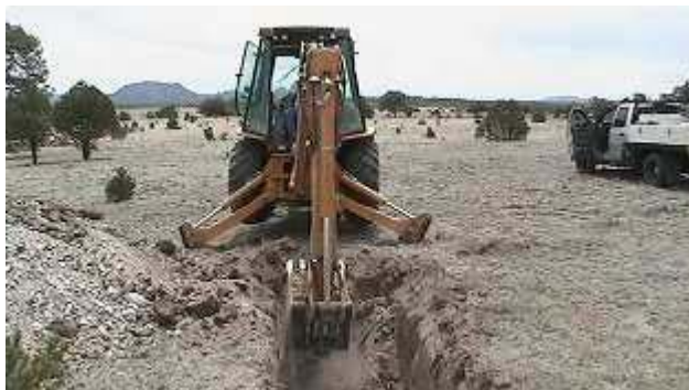
Рисунок 4 - Рытье прямоугольного котлована.
