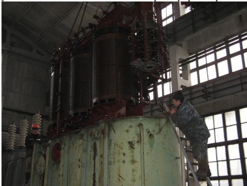
Рисунок 18 – Подъем активной части трансформатора
