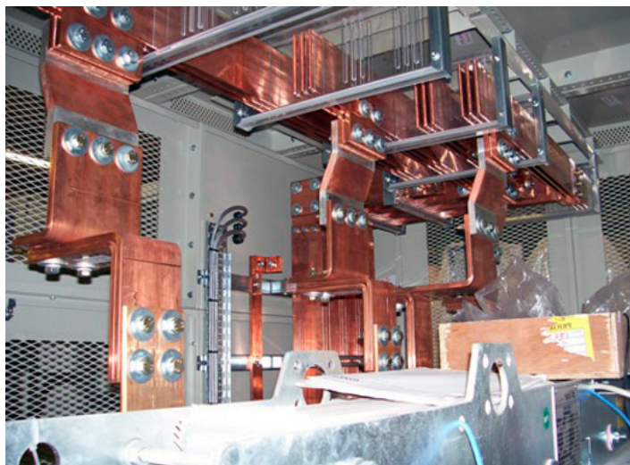
Рисунок 7 – монтаж ошиновки
