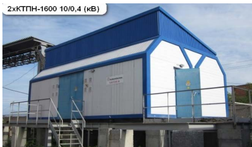
Рисунок 19 – Двухтрансформаторная подстанция
