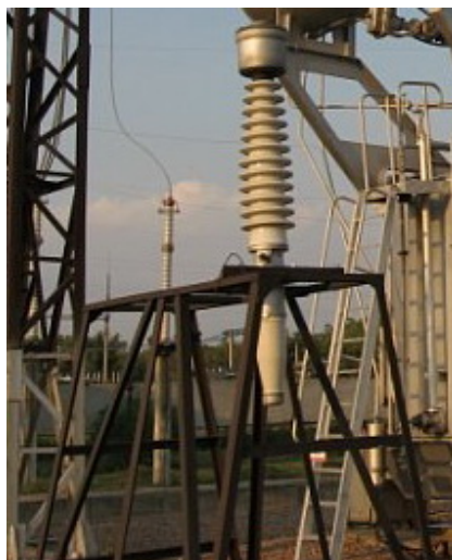
Рисунок 9 – Хранение ввода в вертикальном положении
