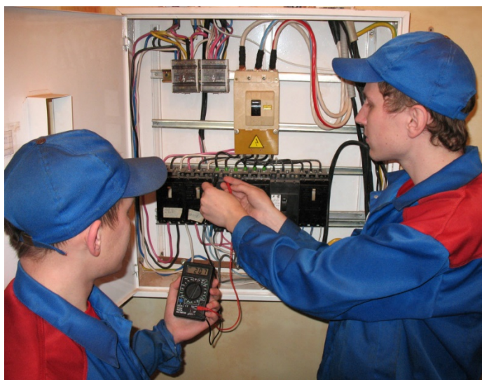
Рисунок 5 – Испытания КРУ
