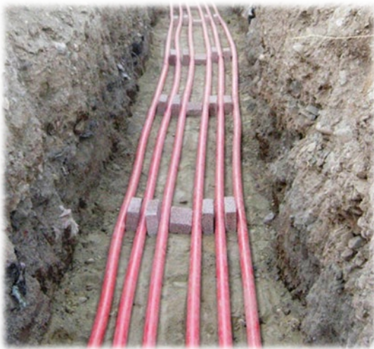
Рисунок – Прокладка кабеля в траншее
