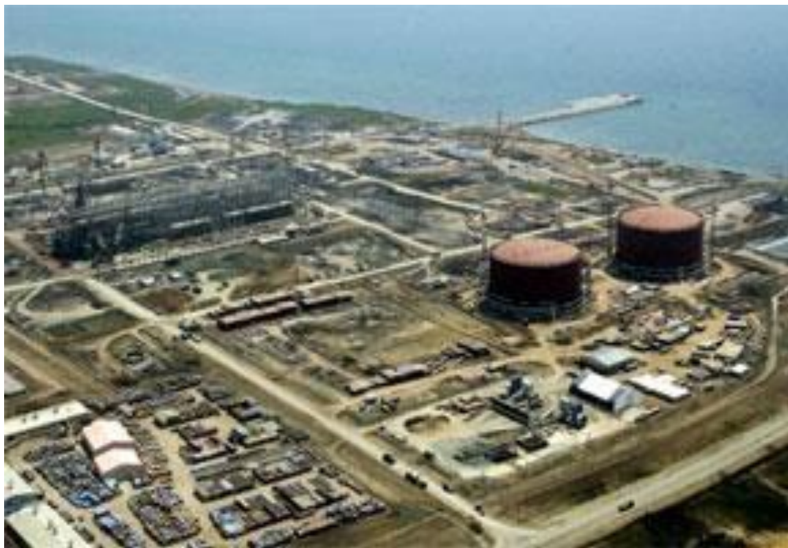
Рисунок 1. – Строительство завода в рамках проекта «Сахалин-2»
