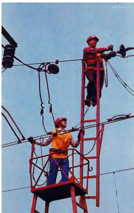
Рисунок 10 – осмотр изоляторов
