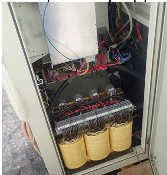
Рисунок 5 – Испытания измерительных трансформаторов
