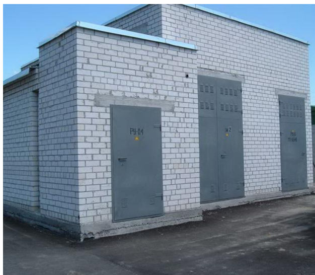
Рисунок 12 – Трансформаторная подстанция закрытого типа
