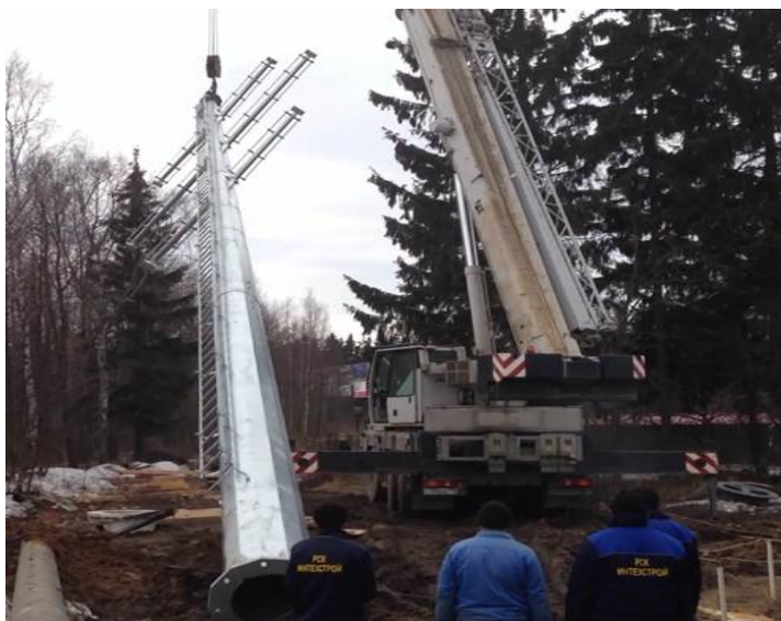
Рисунок 8 – установка опоры с помощью крана
