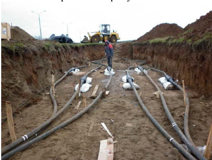
Рисунок 10 – Прокладка кабеля
