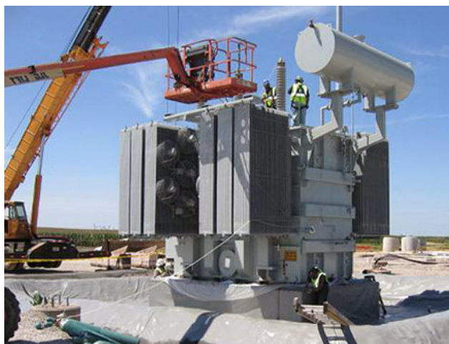
Рисунок 10 – Сборка трансформаторов
