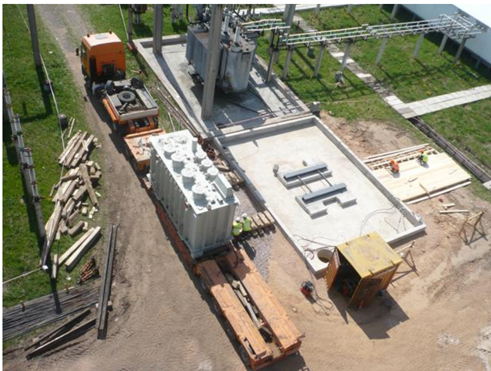
Рисунок 5 – Разгрузка трансформатора с автотрайлера домкратами
