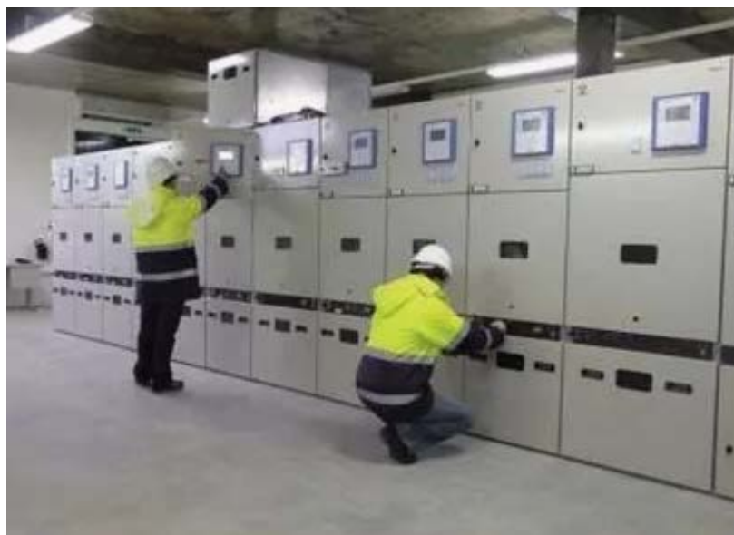
Рисунок 1 – Монтаж КРУ
