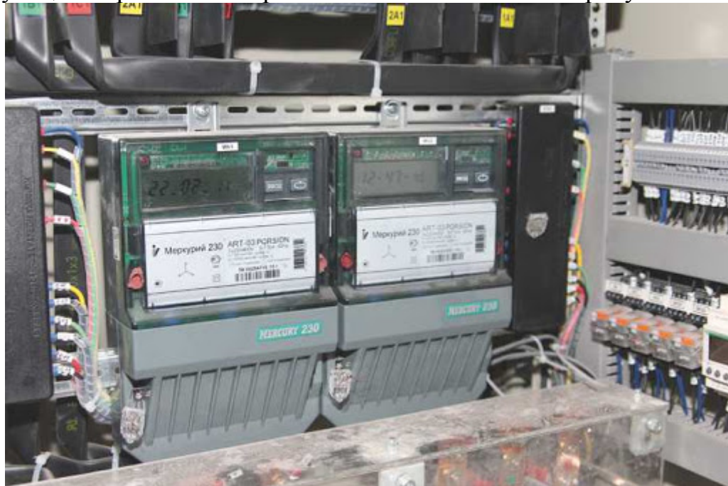
Рисунок 14 – Наладка системы АСКУЭ
