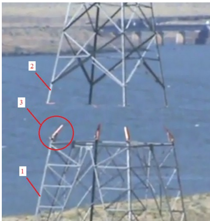
Рисунок 9 - Монтаж опор наращиванием с помощью вертолета
