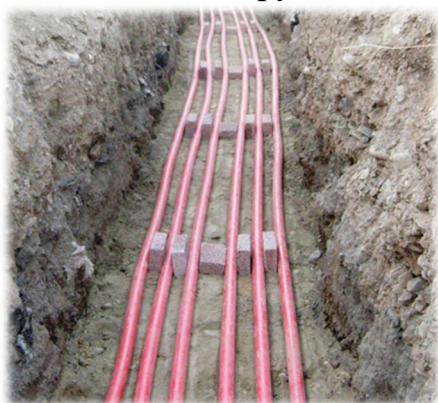
Рисунок 6.3 – Прокладка кабеля в траншее
