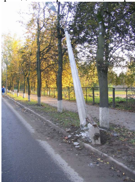
Рисунок 2 – Повреждение опоры автомобильным транспортом
