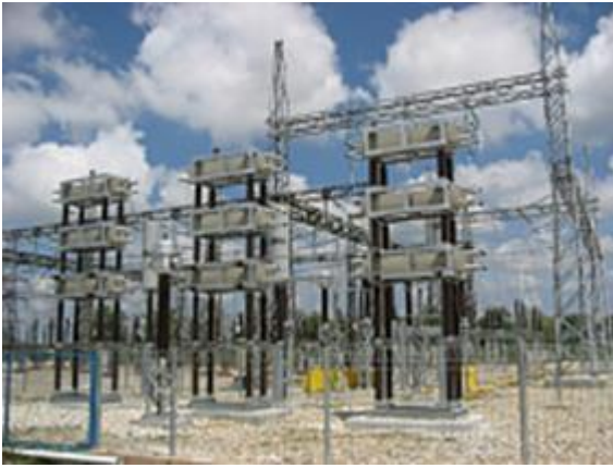
Рис. 7.6 Общий вид монтажа конденсаторной батареи 220 кВ
