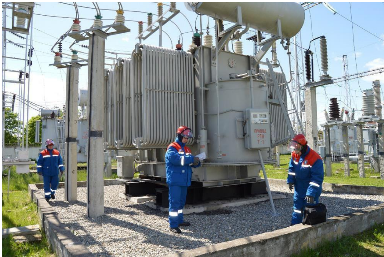
Рисунок 2. Осмотр подстанций 110-35 кВ.
