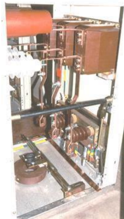
Рис. 7.5. Кабельный отсек
