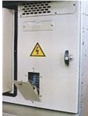
Рисунок 2.8.5 - Смотровые окна. Визуальное наблюдение видимого разрыва контактов разъединителя. Рисунок 8.6 - Лампы внутреннего освещения. Заменяются без открывания дверей.
