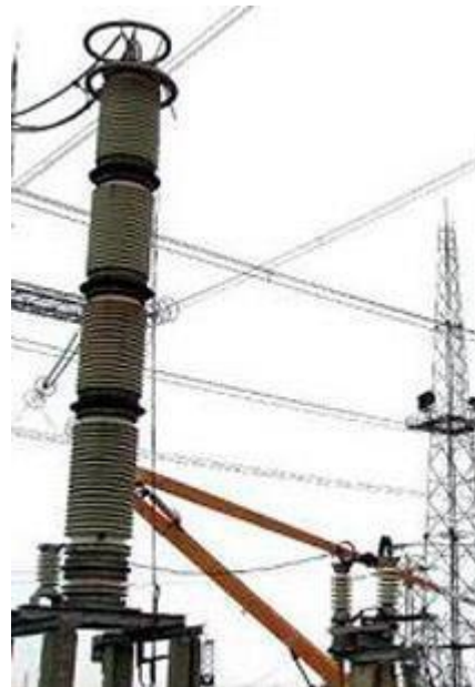
Рис. 3.7 – Емкостный делитель напряжения НДЕ-500, а – схема; б – установка НДЕ-500; 1 – делитель напряжения; 2 – разъединитель; 3 – трансформатор напряжения и дроссель; 4 – заградитель высокочастотный; 5 – разрядник; 6 – привод.
