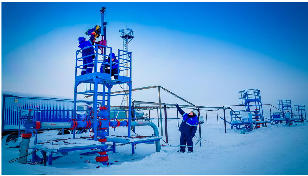
Рисунок 1 – Установка проволочной лубрикаторной установки на устье действующей скважины
