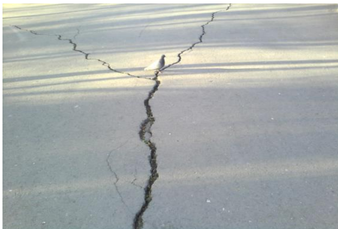
Рисунок 10.1 – Разрыв дорожной одежды в результате пучения грунта земляного полотна
