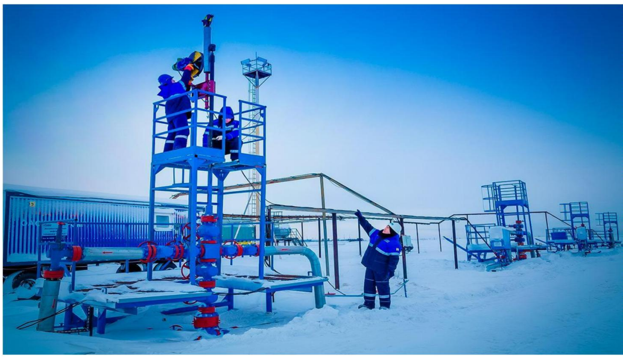
Рисунок 1 – Установка проволоочной лубрикаторной установки на устье действующей скважины
