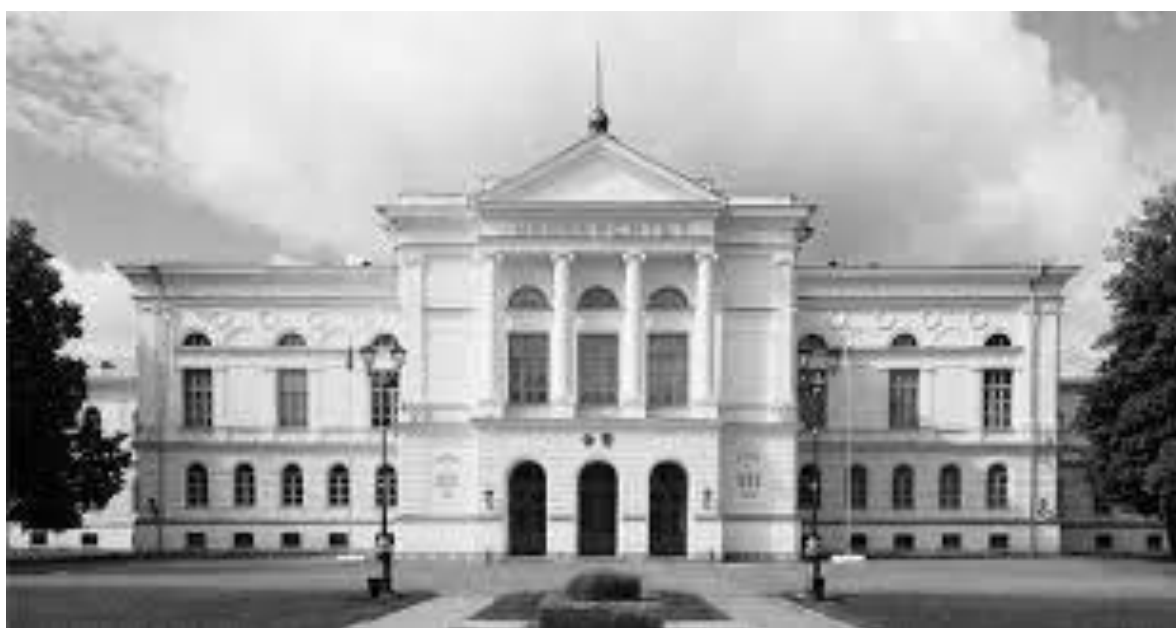
Рис. 1. Главный корпус НИ ТГУ
