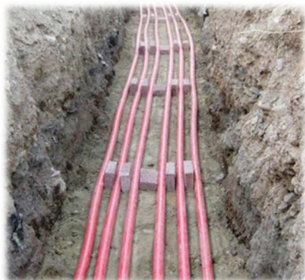
Рисунок 2.3 – Прокладка кабеля в траншее
