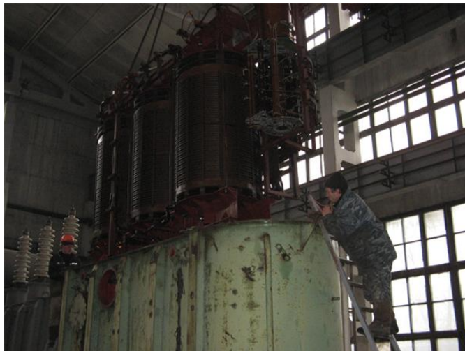
Рисунок 4.5 – Подъем активной части трансформатора
