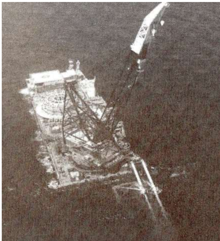
Рисунок 7 - Баржа-трубоукладчик с барабаном "Hercules" в процессе сооружения трубопровода
