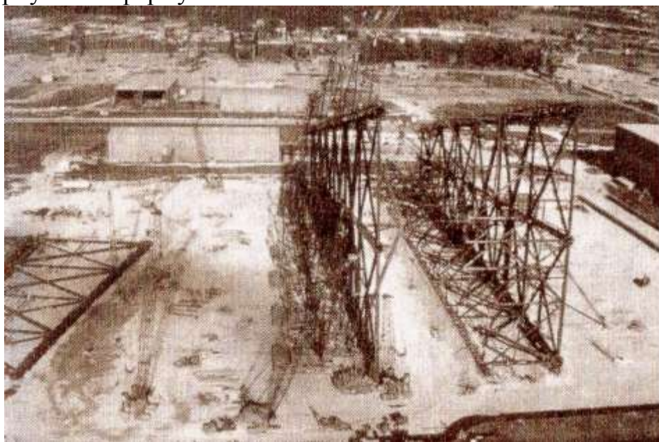
Рисунок 4 - Строительные краны, скручивающие стальную раму для каркаса глубоководной системы
