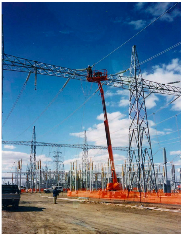
Рисунок 13 – Монтаж гибкой ошиновки
