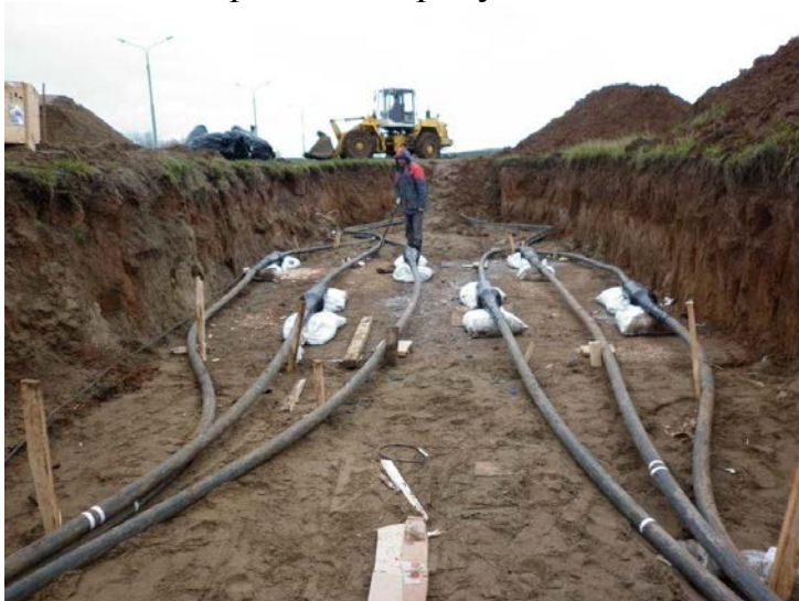
Рисунок 10 – Прокладка кабеля
