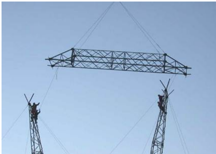
Рисунок 6 – Установка опоры
