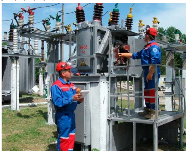
Рисунок 3 – Монтаж КРУ
