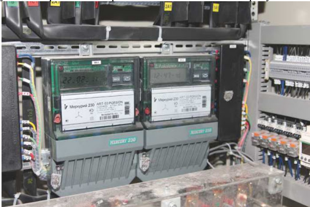
Рисунок 14 – Наладка системы АСКУЭ
