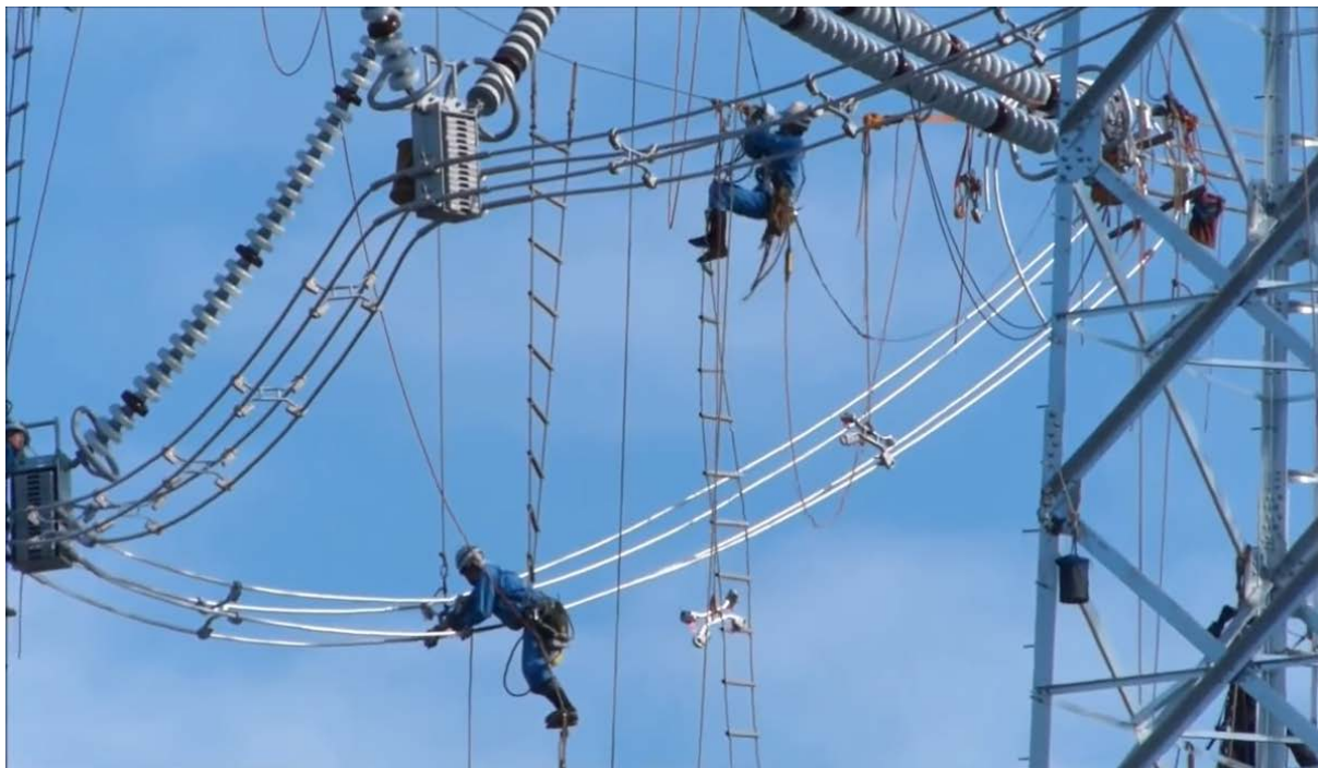
Рисунок 9 – Ремонт изоляторов
