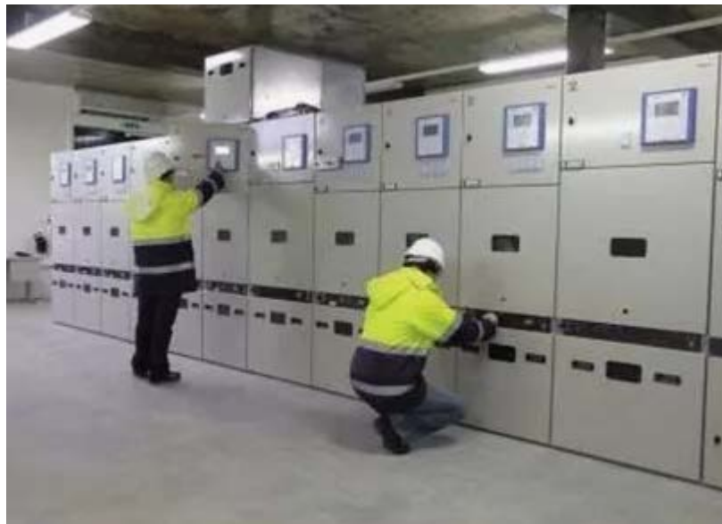
Рисунок 1 – Монтаж КРУ
