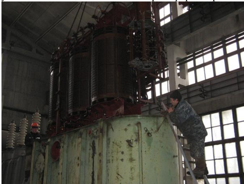
Рисунок 18 – Подъем активной части трансформатора
