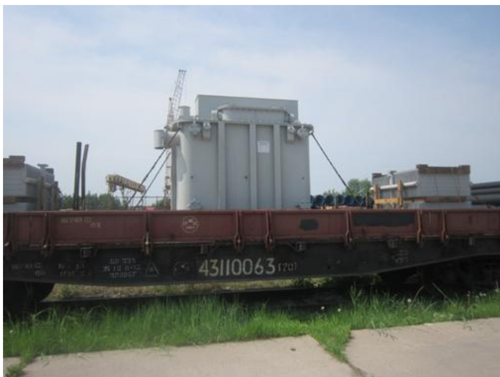
Рисунок 2 – Перевозка трансформатора, его узлов и деталей ж/д транспортом
