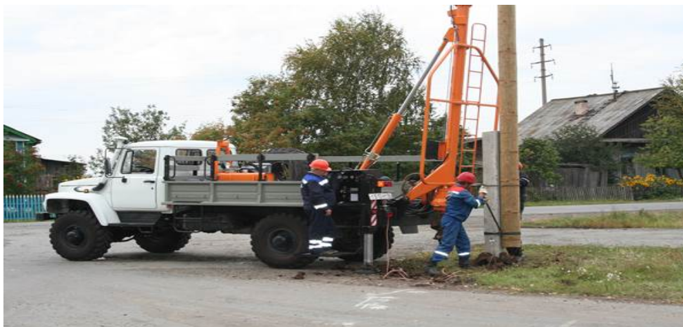
Рисунок 7 – установка опор бурокатной машиной.
