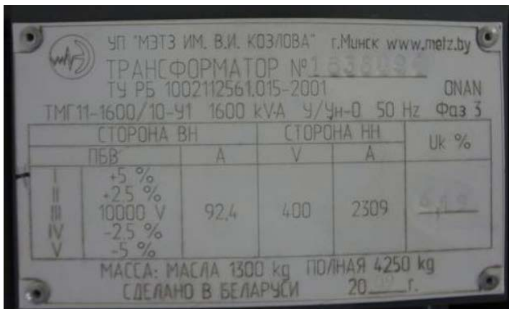
Рисунок 22 – Основные тех. данные трансформатора
