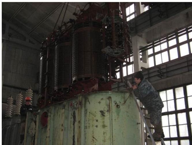
Рисунок 8.5 – Подъем активной части трансформатора
